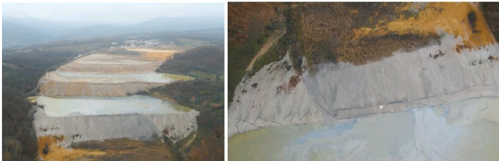
Slika 2. Brane za jalovište rudnika Lece u selu Gazdare, Medveđa
